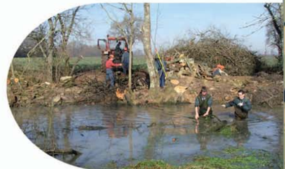
Mare en cours de restauration. © G. Faupin
